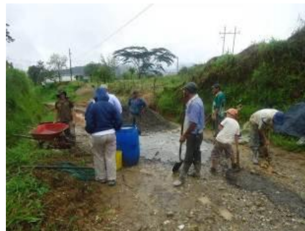
Foto 3-63. Convite para la construcción de rieles en la vía El Chocó-EI Molino
