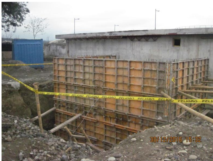
Fotografía 5.3.4-10 Nombre del Sitio: Recinto Tabule Coordenadas: UTM WGS84 Zona 17N 652285/105374 Fecha: Diciembre, 2016 Fotografía: Marta Tur Descripción: Vista de la construcción de tanques municipales de agua potable.
