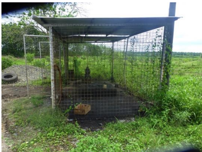
Fotografía 5.1.4-6 Fecha: 2016/12/30 Fotografía: Mark Thurber Descripción: Pozo de las piscinas en la hacienda Viviana Katherine, propiedad de Carlos Barrero. Profundo, carcasa con tubo de acero. bomba a diésel (retirada para mantenimiento), no funcionando.
