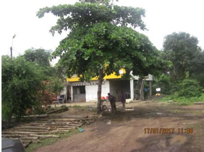
Fotografía 5.3.4-5 Nombre del Sitio: Pantanal Coordenadas: 661562/9828520 Fecha: 2017/01/17 Fotografía: Marta Tur Descripción: Vista de la casa de cemento de dos (2) plantas del Sr. Portilla ubicada al noroeste de EXTRACOSTA.
