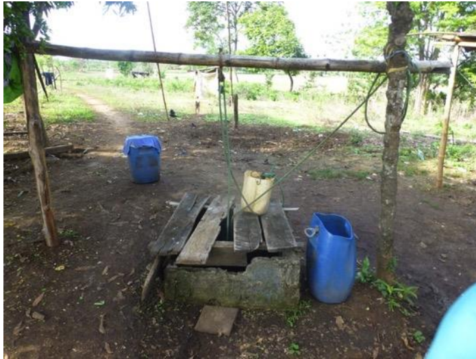
Fotografía 5.1.4-1 Fecha: 2016/12/30 Fotografía: Mark Thurber Descripción: Pozo del recinto El Fastidio (también conocido como Pajonal). Somero, con carcasa de cemento y ladrillos, sistema de cuerda y cubo para extracción del agua.
