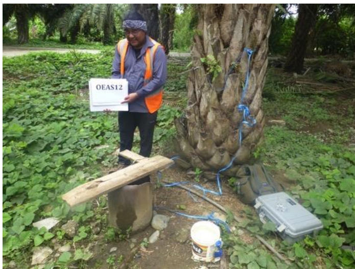
Fotografía 5.1.4-3 Fecha: 2016/12/30 Fotografía: Mark Thurber Descripción: Pozo de la Familia de Obal Mora en la plantación Agro Aéreo. Somero, carcasa con tubo de acero, sistema de cuerda y cubo para extracción del agua.
