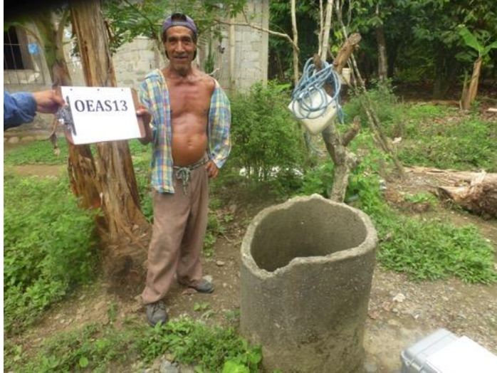
Fotografía 5.1.4-4 Fecha: 2016/12/30 Fotografía: Mark Thurber Descripción: Pozo de la Familia de Jesús Bajaña, recinto El Batán. Somero, carcasa con tubo de concreto, sistema de cuerda y cubo para extracción del agua.
