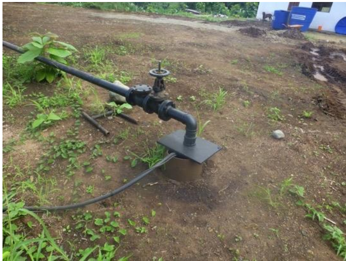
Fotografía 5.1.4-2 Fecha: 2016/12/30 Fotografía: Mark Thurber Descripción: Pozo en el sitio del proyecto de EXTRACOSTA. Profundo, carcasa con tubo de acero, bomba electro-sumergible.
