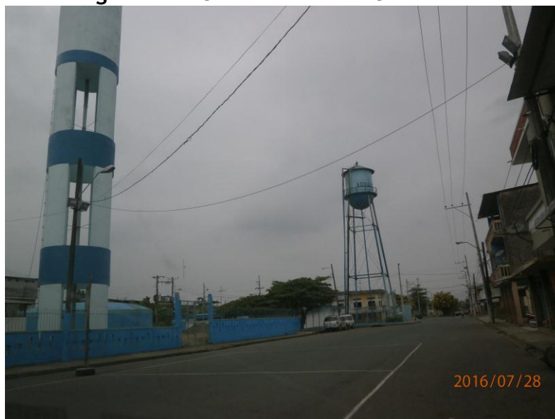
Figura 5-29: Torres de Agua en el Centro Poblado Cantón Pueblo Viejo
