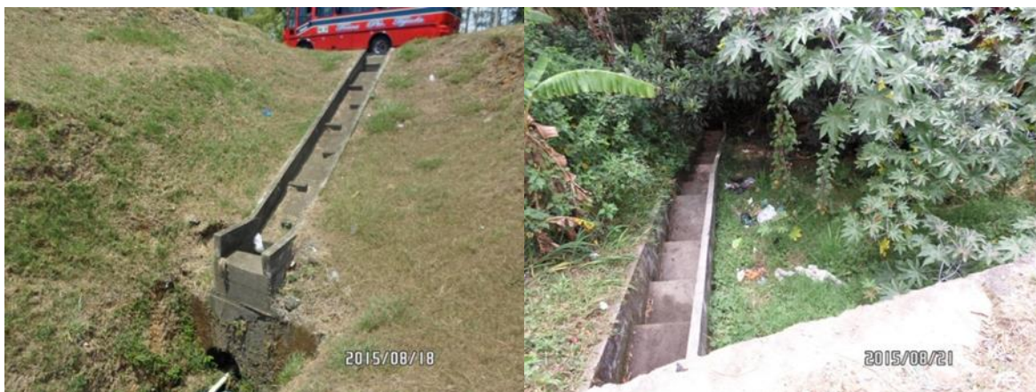
Foto 3.14 Canales y disipadores de energía existentes Fuente: TYPESA Ingenieros Consultores y Arquitectos, 2015. Op Cit
