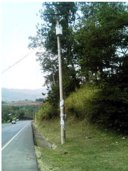
Foto 3.17 Poste con transformador
