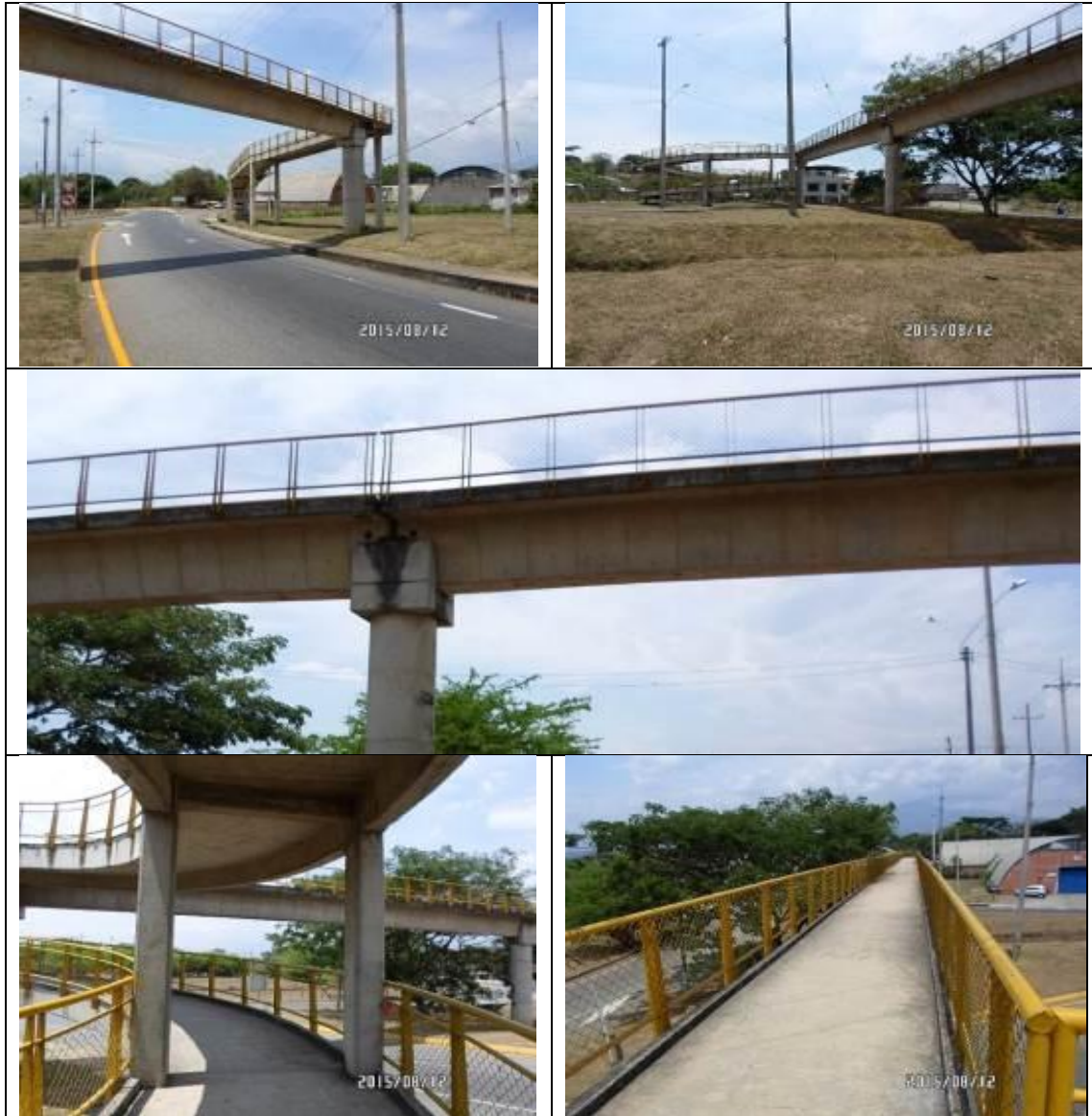
Fotografía 6 Estado puente peatonal Km 74+600
