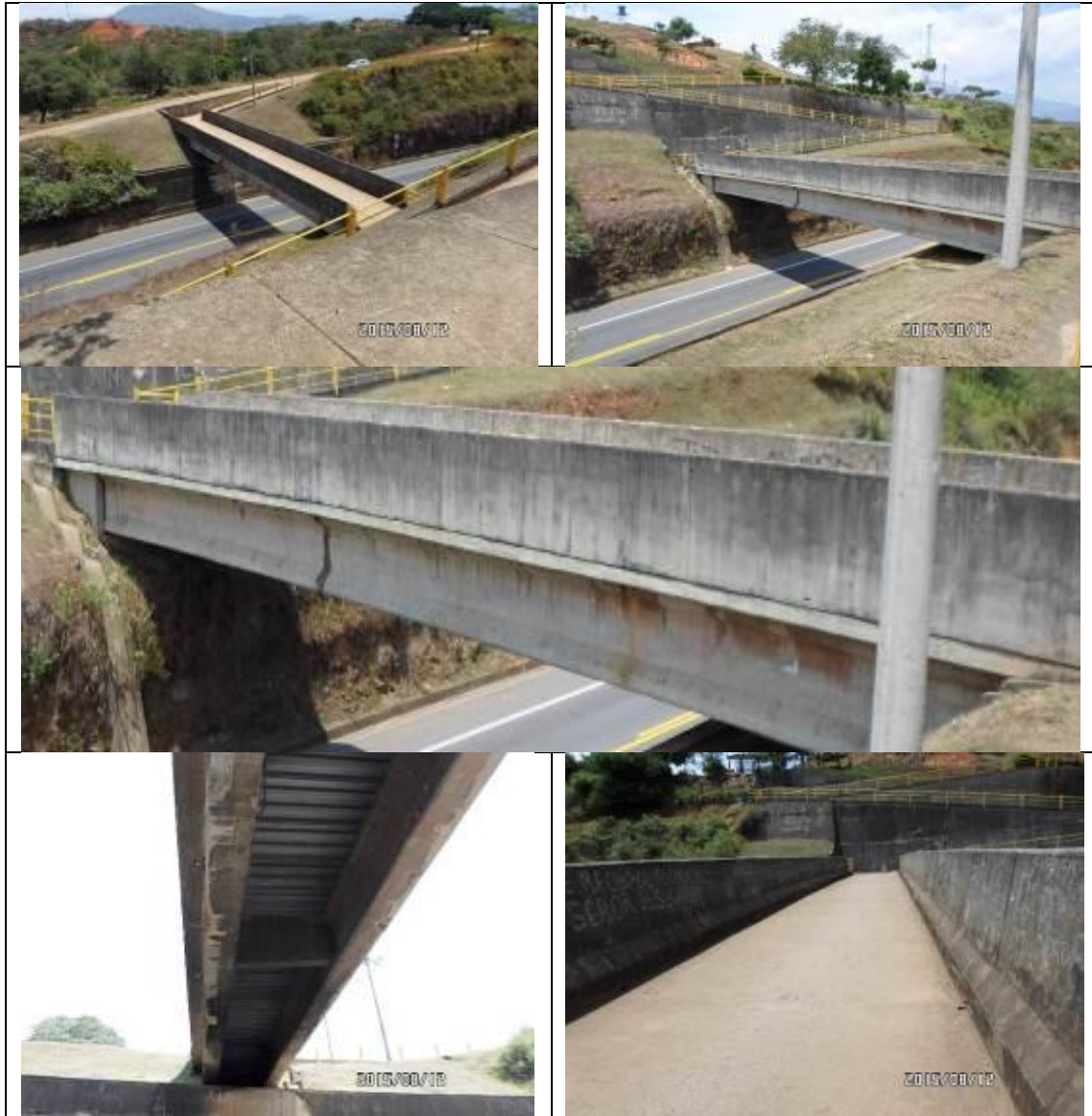
Fotografía 5 Estado Puente peatonal km 72+700
