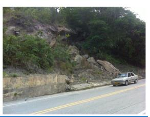
Fotografía 8-41 deslizamiento tipo caída y volcamiento de rocas parte del talud cortado para la vía
