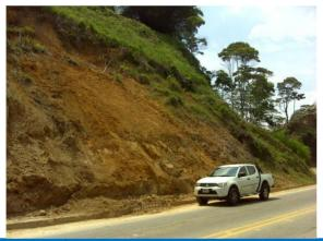
Fotografía 8-40 Proceso denudativo generado por el corte del talud para la construcción de la via.
