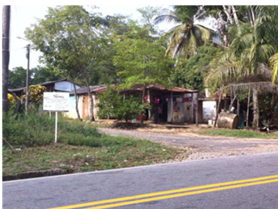
Fotografía 5-1 Paso de poliducto. Vereda la Lisama. Municipio de San Vicente de Chucurí
