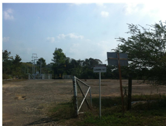
Fotografía 5-2 Pozo 161. Vereda La Lisama 2. San Vicente de Chucurí
