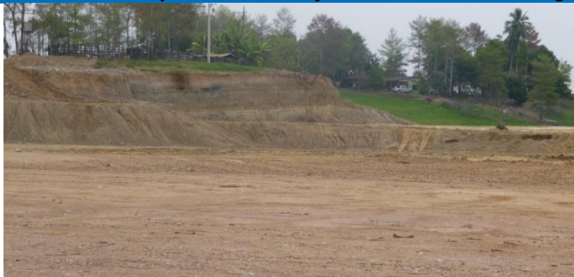
Fotografía 5–29 Sector de explanaciones muy cerca del sitio de la Virgen.
