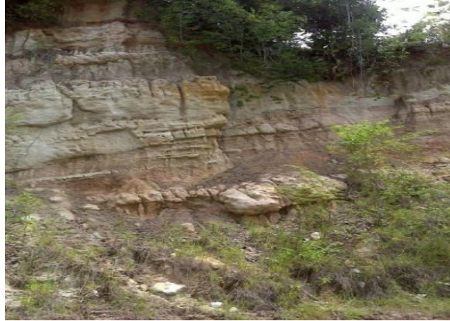
Fotografía 5–5 Talud en donde se ve la estratificación con intercalaciones de arcillolitas arenisca
