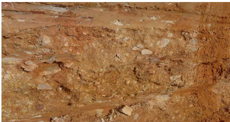
Fotografía 5–2 Corte del talud en depósitos aluviales, se pueden ver los cantos y gravas, sector de la vía que conduce de Zarzal a Barrancabermeja
