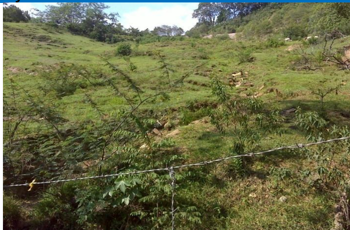
Fotografía 5–35 Sector de deslizamiento sobre la vía existente , en inmediaciones del caserío La playa
