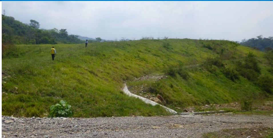
Fotografía 5–28 Lleno de escombros sector de Zodme cerca del sitio de la presa
