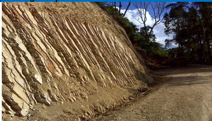
Fotografía 5–12 Corte de talud vial, rocas de la formación la Luna N45E/65NW. Sector de la vía para llegar al punto La Azufrada.
