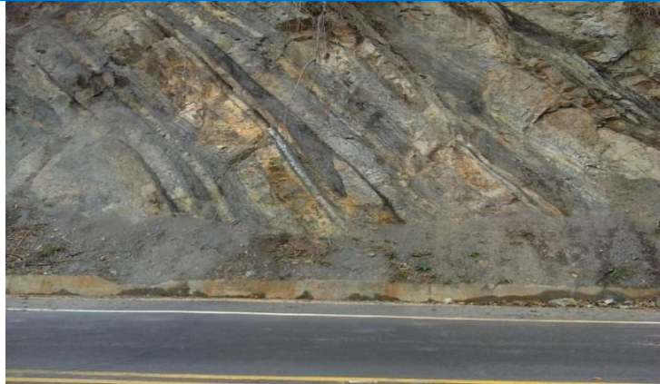
Fotografía 5–13 Corte de talud vial, se puede ver la intercalación de shales con areniscas muy cerca de la estación Guayacán
