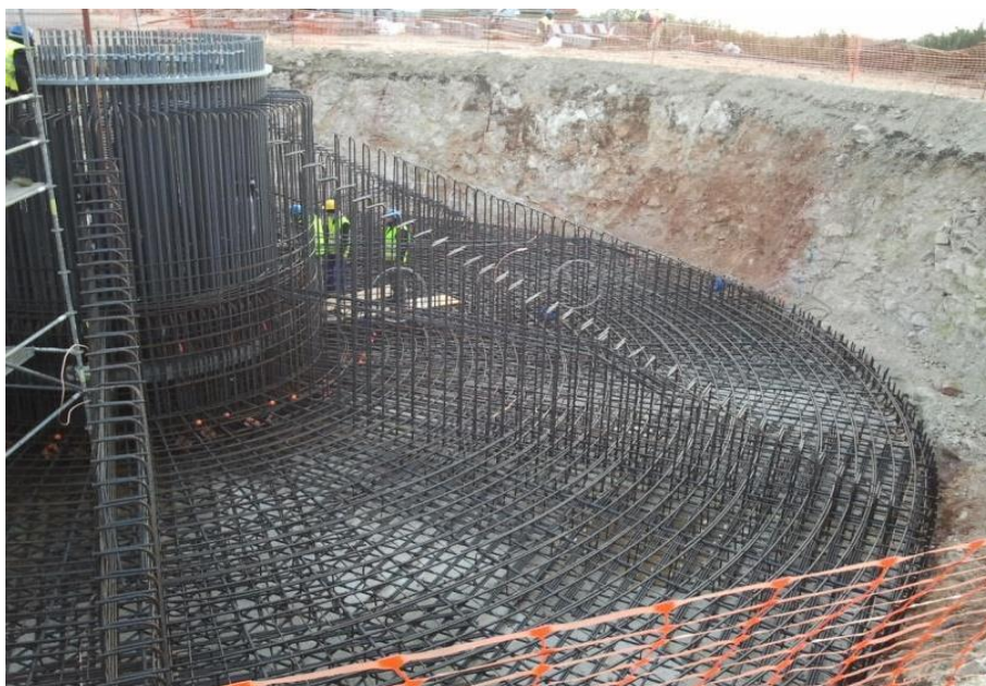
Figura Nº 20. Fotografía típica de la fundación de un aerogenerador.
