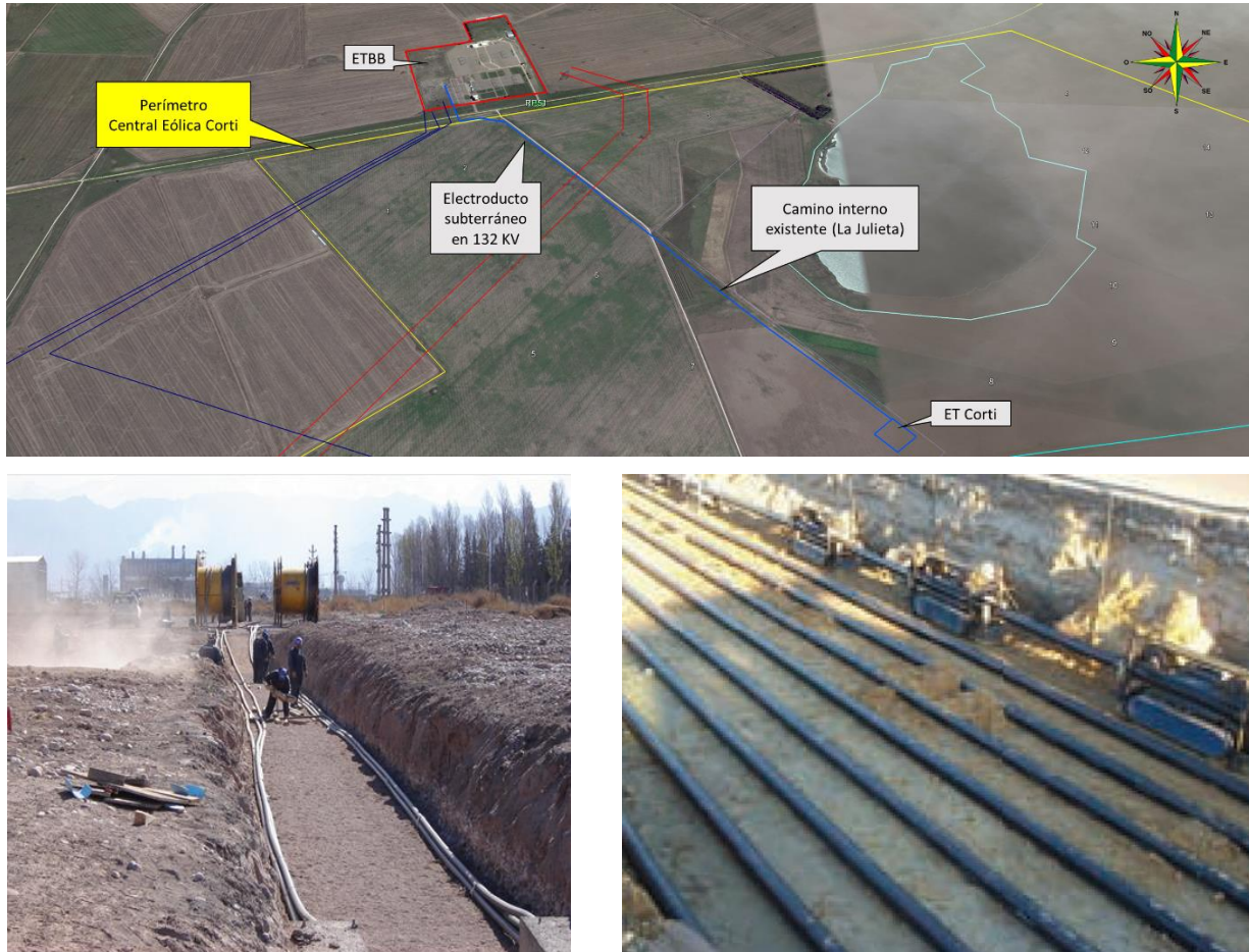
Figura Nº 7. Imagen Google con la ubicación preliminar del electroducto subterráneo 1x132 KV, y dos fotografías típicas de montaje de éste tipo de instalaciones (Fuente: Prysmian Group).
