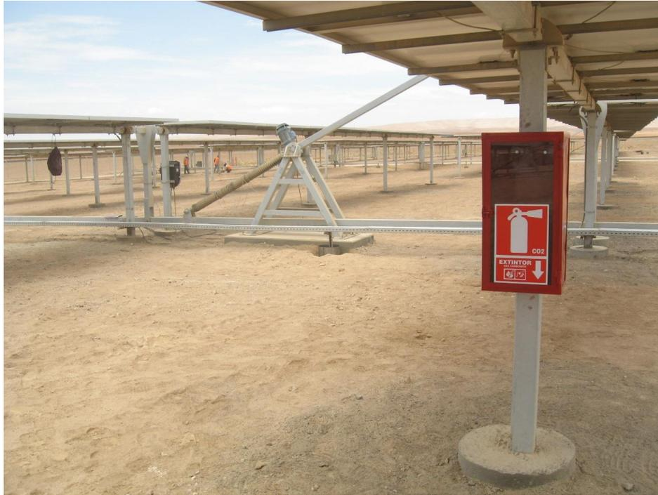
Fotografía 11. Vista general de un parque fotovoltaico. Se observa el tipo de cimentación así como equipo contra incendio.
