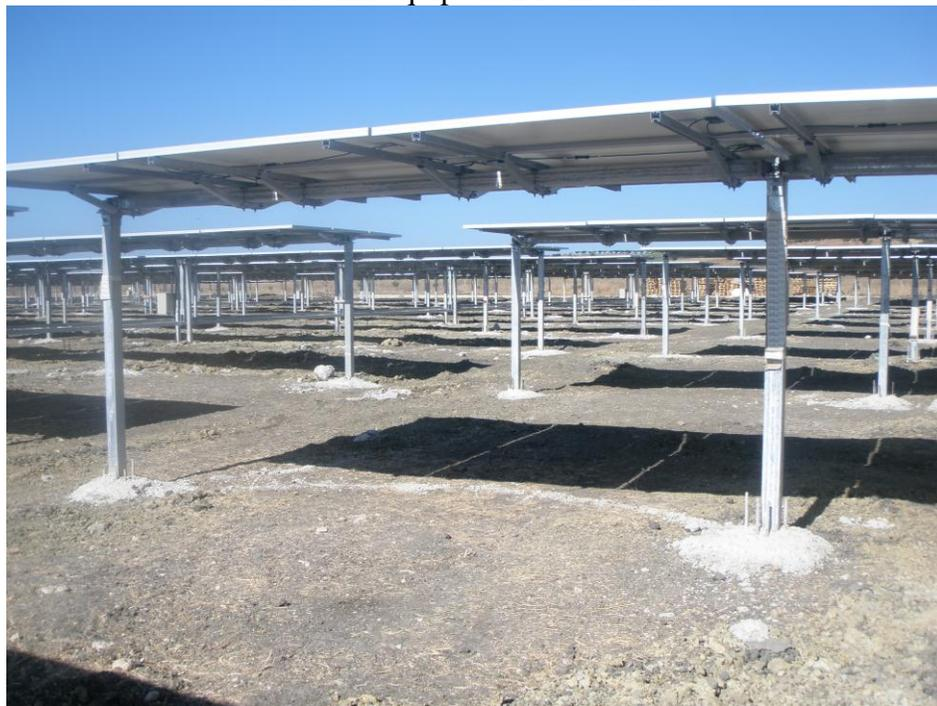
Fotografía 12. Detalle de la cimentación y soportes empleados para los paneles solares. Se observa que no existe sellamiento ni confinamiento del suelo. Los paneles permitirán el paso de luz, viento, lluvia. También se llama la atención sobre el área de suelo a ocupar se construye a los soportes para los paneles.
