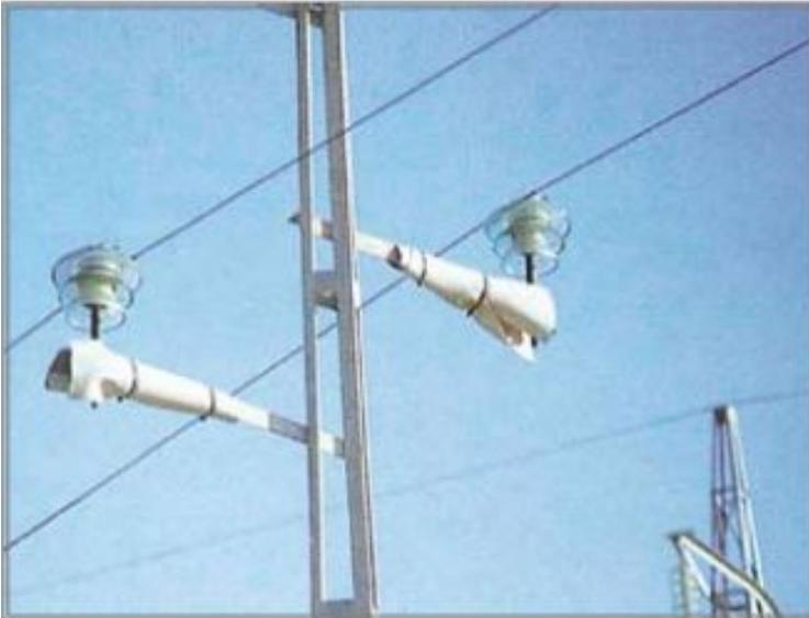
Consiste en el aislamiento parcial de la cruzeta, previene contacto fase-tierra, se cubre con manta aislante la zona de la cruzeta bajo los aisladores, se recomiendan 50 cm. Se pueden utilizar diversos materiales. Tiene un costo bajo con buena eficacia.
