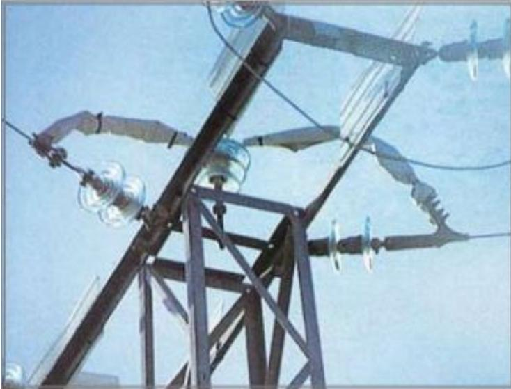
Consiste en un aislamiento parcial de la fase, previene contacto fase-tierra, se cubren los puentes y las grapas con aislante o se sustituye el puente por cable seco, las dimensiones de la cobertura dependen del puente. Se pueden utilizar diversos materiales. Tiene un costo medio con buena eficacia.
