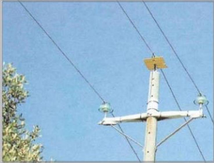
Consiste en el aislamiento parcial de la cruzeta, previene contacto fase-tierra, se cubren con una placa el poste debajo del aislador, las dimensiones de la placa se recomiendan 30x30 cm. Se recomienda plástico. Tiene un costo bajo con buena eficacia.
