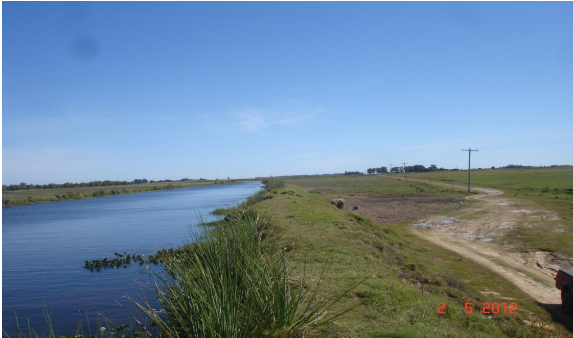
Figura 5.7.6 - Canal de irrigação na porção sudeste da AID (Coordenadas UTM/SAD-69: 319831/6322929).
