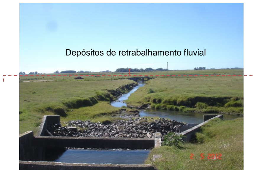
Figura 5.5.8 - Aspecto geral do relevo, vegetação no entorno de canal fluvial que caracteriza a UG4. Coordenadas do ponto de registro fotográfico x=316363, y=6327333 (Visada para nordeste).
