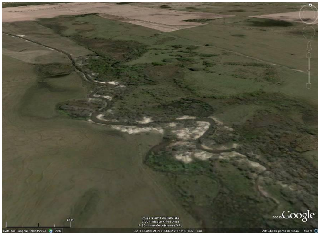
Figura 5.7.11 - Arroio José da Costa Luis localizado na porção norte da AID (Coordenadas Central da Foto UTM/SAD-69: 324025/6330945).
