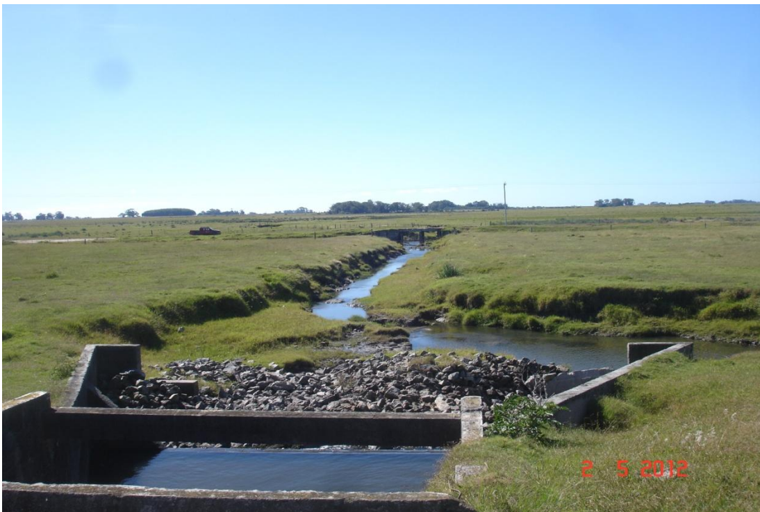
Figura 5.7.20– Imagem do Arroio Pastoreio a jusante do açude de represamento localizado na porção sudoeste da AID (Coordenadas UTM/SAD-69: 316400/6327374).
