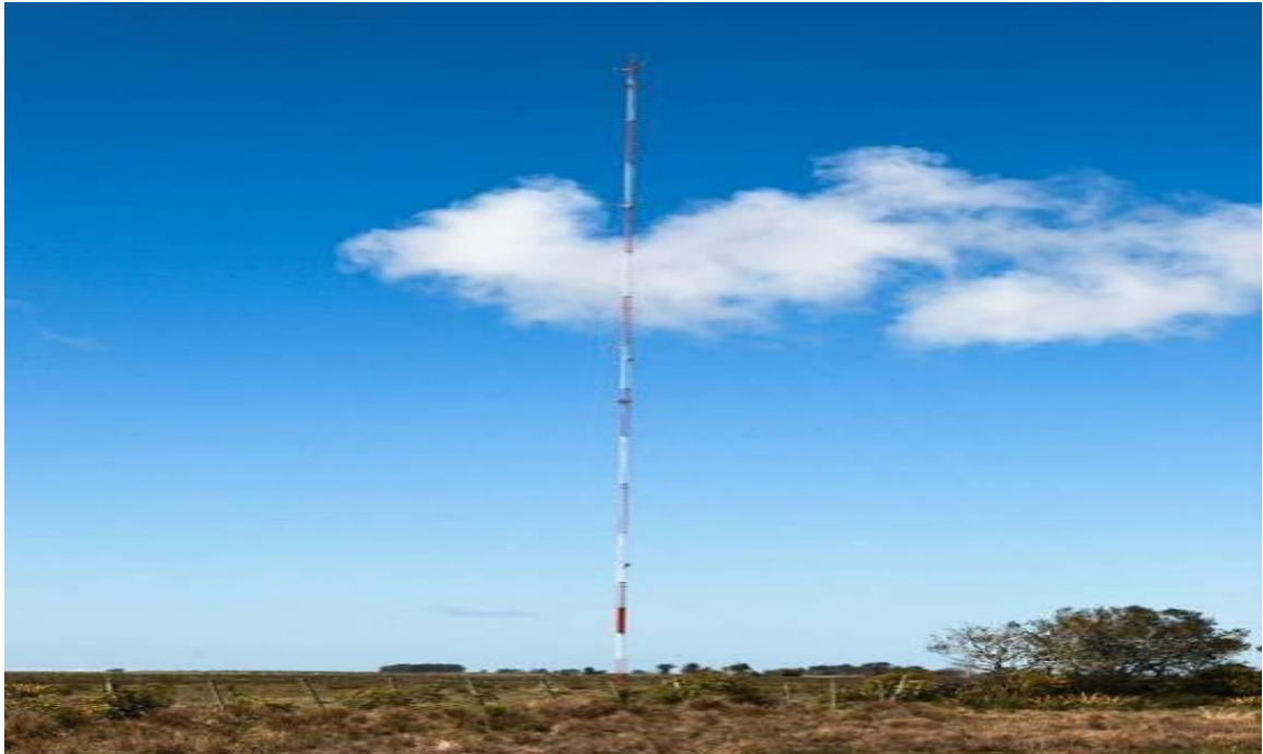
Figura 3.3.1 - Torre anemométrica instalada na área de influência do empreendimento.
