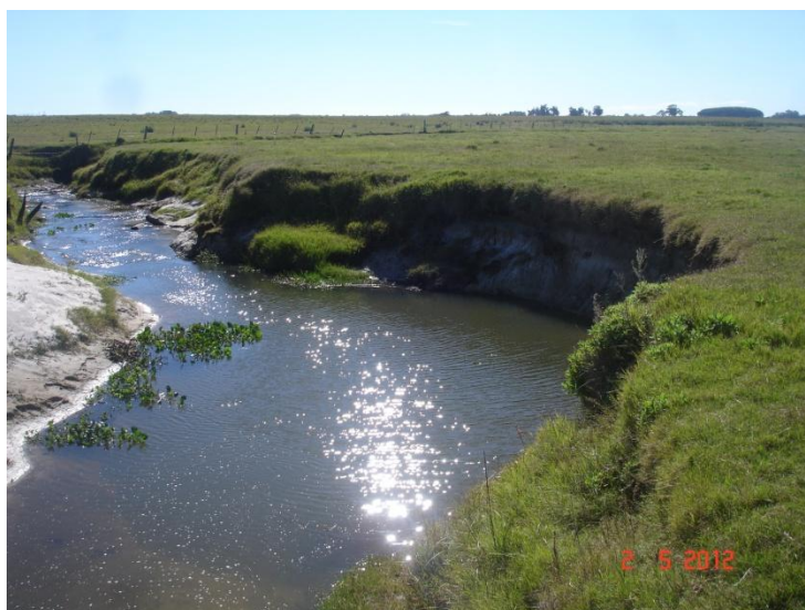
Figura 5.5.11 - Erosão nas margens de canal de drenagem. Situado no ponto de coordenadas UTM (SAD69) x=316462, y=6327399 (Visada para nordeste).
