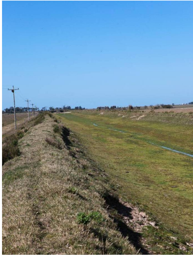
Figura 5.7.5 - Canal de irrigação na porção norte da AID (Coordenadas UTM/SAD-69: 321880/6333011).
