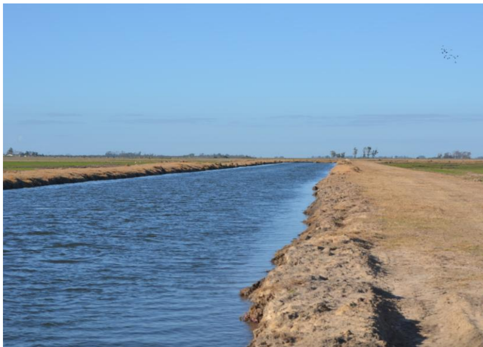
Figura 6.2.12 - Canal de irrigação principal durante fase de bombeamento.
