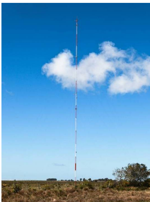
Figura 3.3.1 - Torre anemométrica instalada na área de influência do empreendimento.
