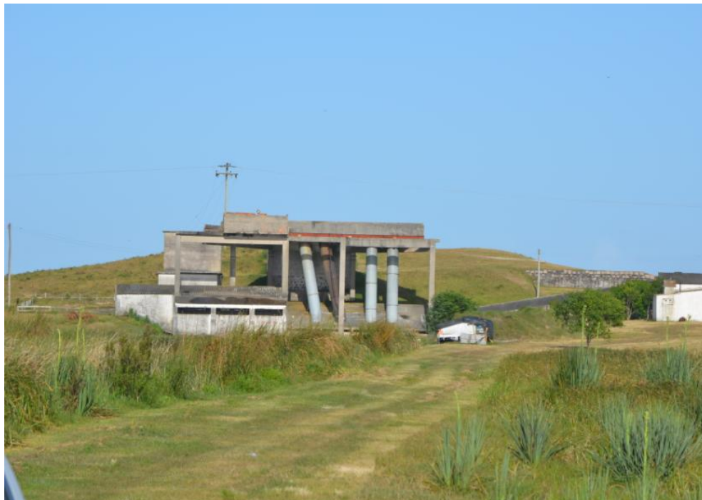
Figura 6.2.11 - Estação de bombeamento nas proximidades da Lagoa Mangueira.
