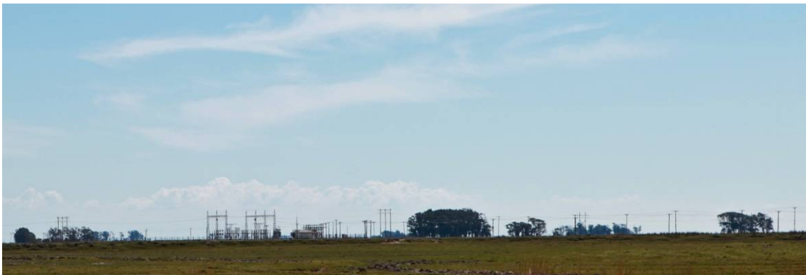
Figura 3.4.5 - Vista da SE Marmeleiro
