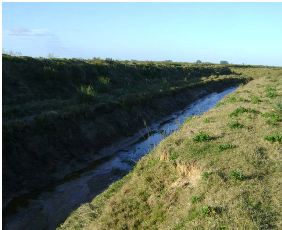
Figura 6.2.8 - Canal de irrigação principal fora de período de bombeamento.
