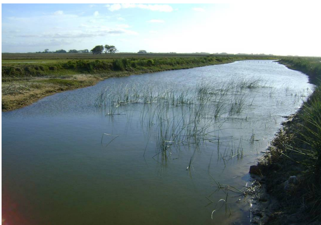
Figura 6.2.34 - Canal mestre de irrigação que entrecorta a porção central da AID no sentido leste-oeste, trazendo água da Lagoa Mangueira para os campos de arroz.
