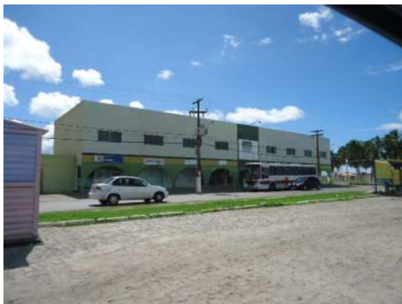
Figura 146. Galerias comercial localizada na Av. Oceânica, nas proximidades da rótula de conexão da Avenida Oceânica com a rodovia SE-100.
