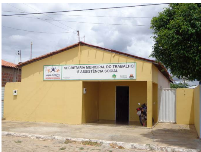
Foto: Geoconsult – PI, fevereiro, 2015.
