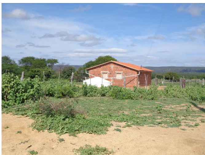
Foto 6.108 – Reservatório de água tipo cisterna instalada no domicílio de Poço de Emburana.
