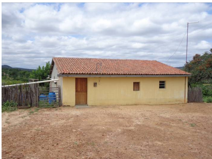
Foto 6.115 – Domicílio particular situado na área central da localidade de Mimoso, estruturada em alvenaria.
