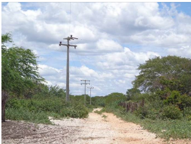
Foto 6.62 – Rede de transmissão de energia rural chegando na localidade de Mocambo .
