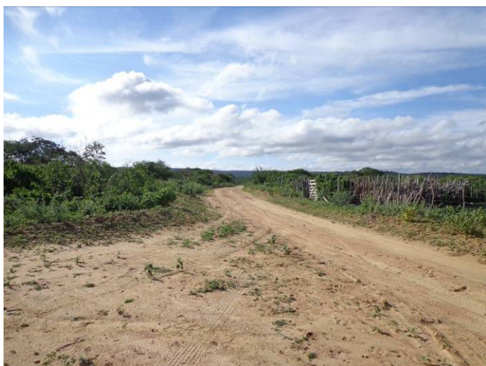
Foto 6.112 – Estrada de acesso principal para a localidade de Poço da Emburana.
