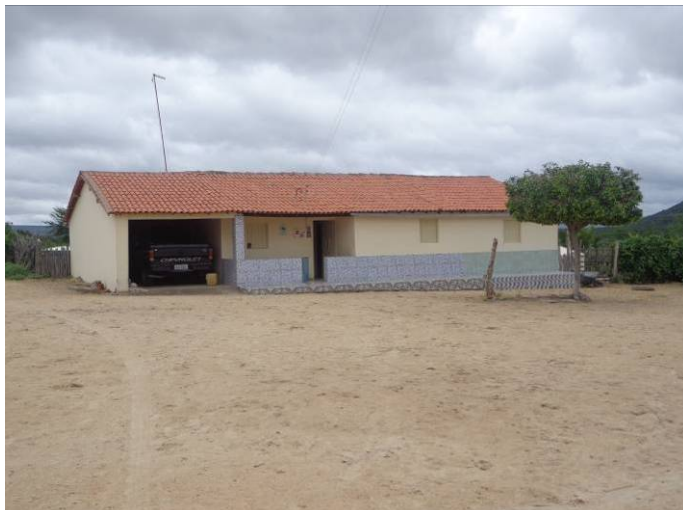
Foto 6.90 – Infraestrutura residencial edificada em alvenaria com revestimento, situada na parte central da localidade de Manguinha.
