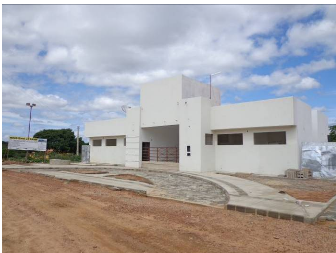
Foto 6.123 – Unidade de Saúde em fase de conclusão instalada na sede da localidade de Mimoso.
