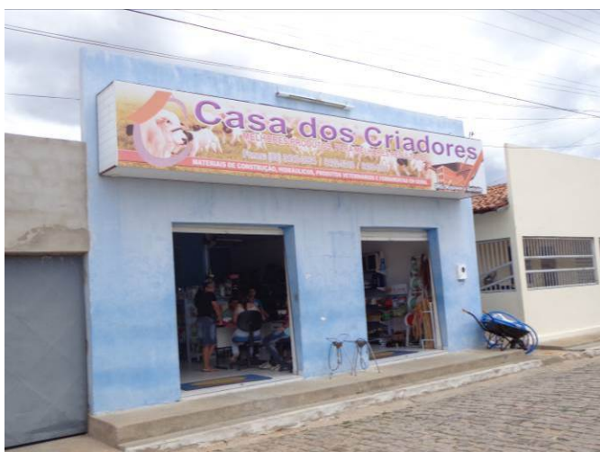
Foto: Geoconsult- Pi, fevereiro, 2015.
