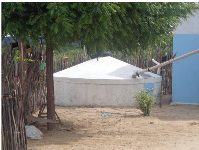
Foto 6.71 – Cisterna instalada em uma residência da localidade de Malhadinha.
