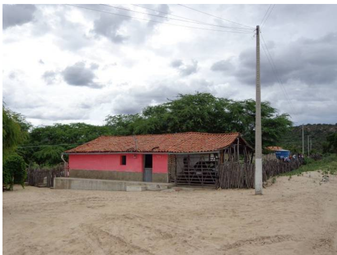
Foto 6.86 – Vista da rede de eletrificação da localidade de Olho D'Água.
