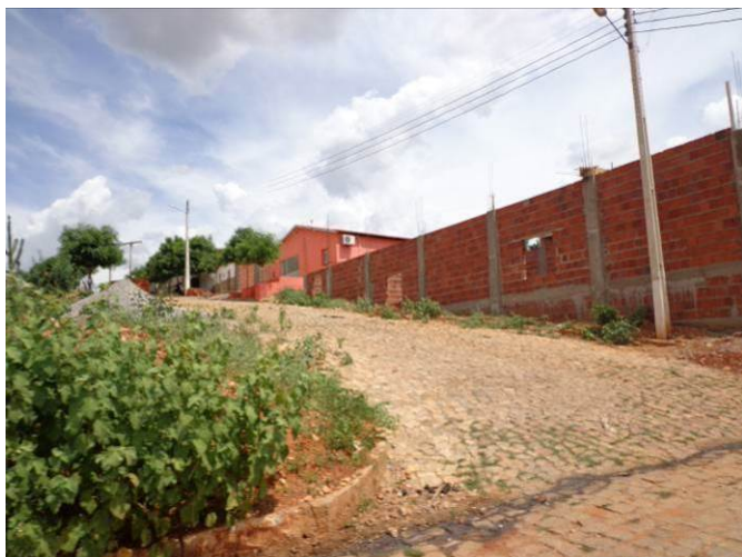
Foto: Geoconsult – PI, fevereiro, 2015.
