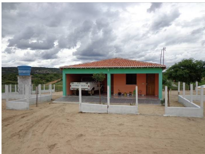
Foto 6.83 - Infraestrutura residencial estruturada em alvenaria, situada na localidade de Olho D'água.
