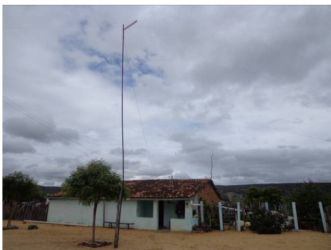
Foto 6.94 – Antena para celular rural instalada em frente a residência do agente de saúde da localidade de Manguinha.
