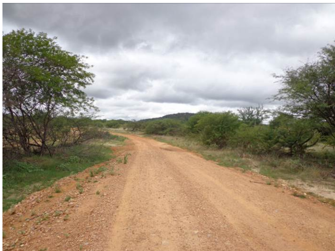
Foto 6.95 – Estrada de acesso para a localidade de Manguinha, estruturada com revestimento natural compactado.
