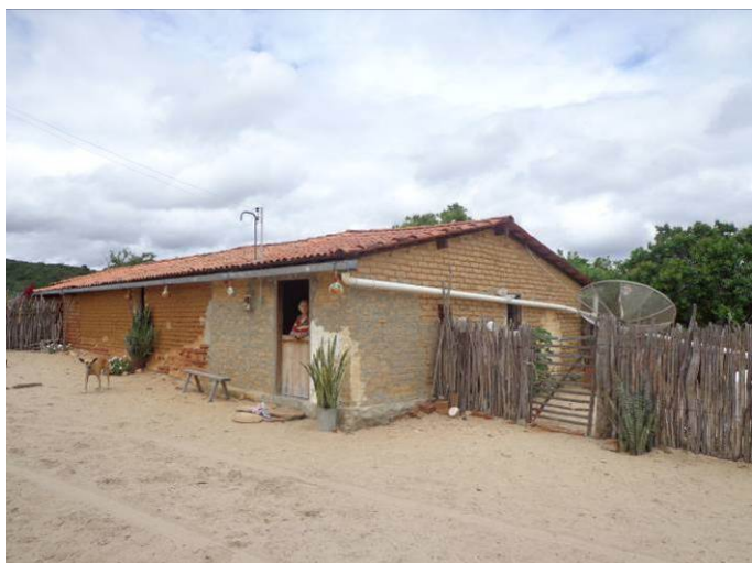
Foto 6.91 – Residência estruturada em alvenaria sem revestimento situada na localidade de Manguinha.
