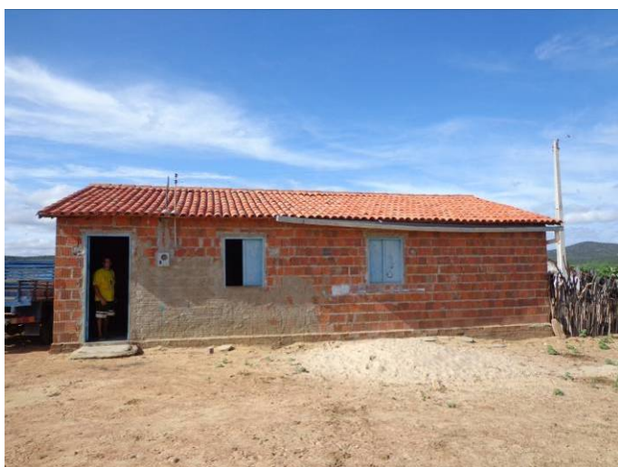
Foto 6.107 – Domicílio tipo residencial estruturado em alvenaria sem revestimento.
