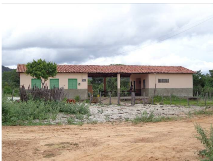
Foto 6.65 – Unidade Escolar João Elói Coelho de Ensino Infantil e Fundamental, instalada na sede da localidade de Mocambo.
