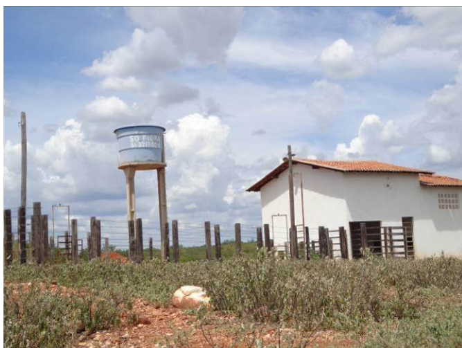
Foto: Geoconsult – PI, fevereiro, 2015.
