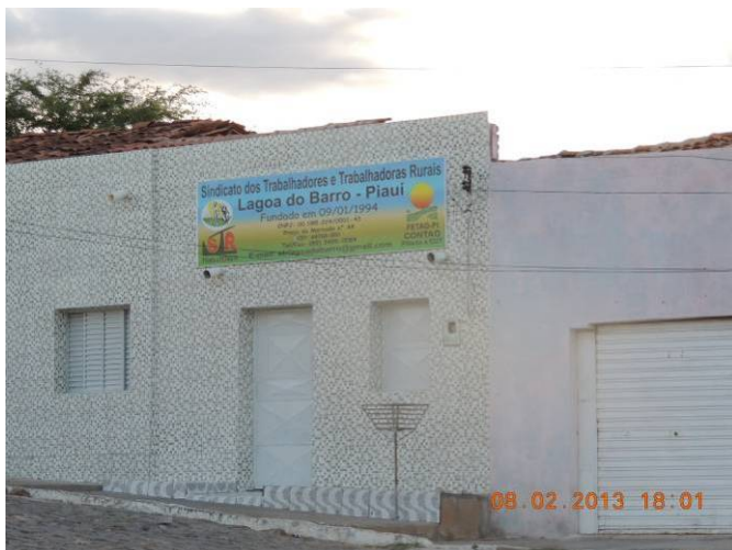
Foto: Geoconsult – PI, fevereiro, 2015.
