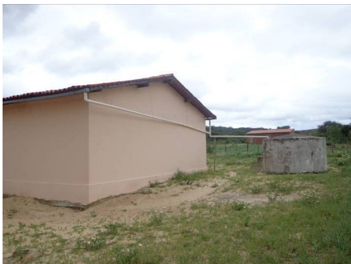
Foto 6.92 – Abastecimento de água realizado pela captação d'água em uma cisterna construída ao lado de uma escola.
