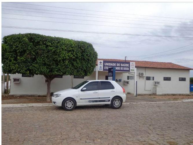
Foto: Geoconsult – PI, fevereiro, 2015.
