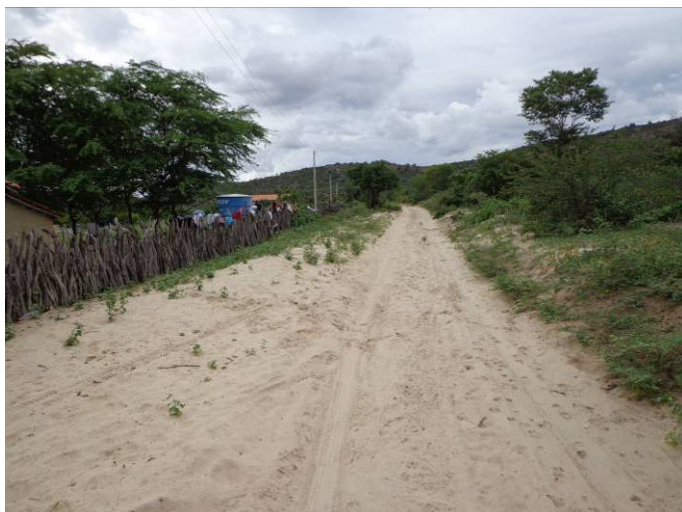
Foto 6.87 – Estrada de acesso para a localidade de Olho D'água, estruturada em terreno natural.
