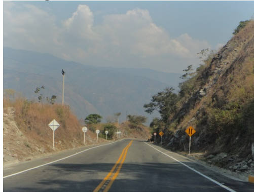
Fotografía 8-37 Vía Autopista al Mar.
