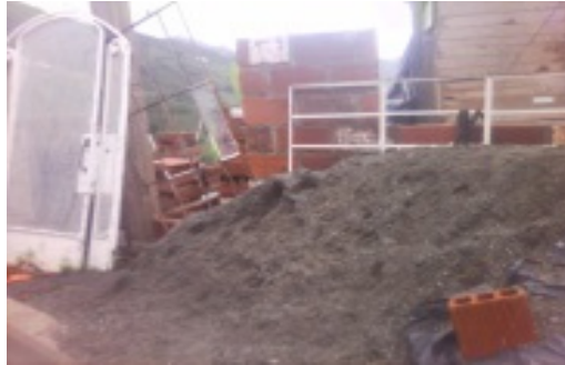
Fotografía 8-22 Desarrollo de construcciones en la zona
