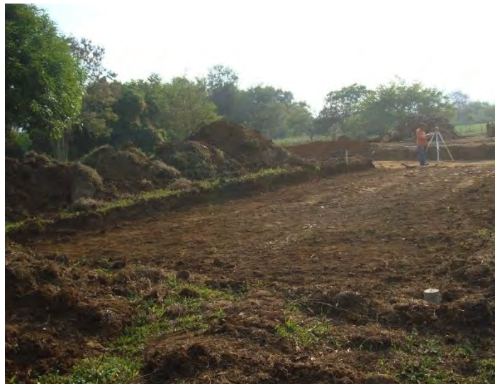
Photo Num. 3.1 Disassembly and cleaning Source: PIO SAS, septiembre 2015.
