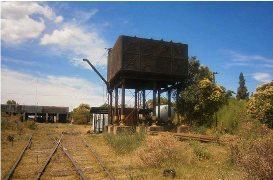
**Figura 9-14 Depósito de agua elevado para alimentación de las máquinas y galpón de máquinas**
