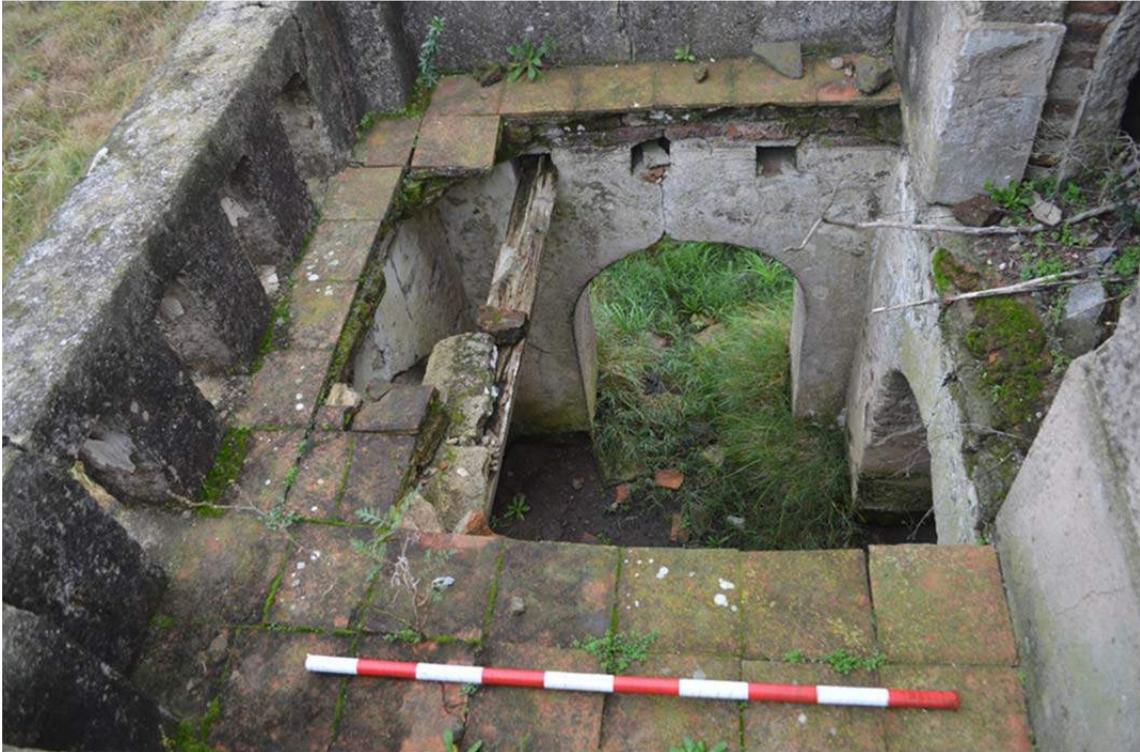
**Figura 9-39** Detalle de balcón derruido y aberturas de medio punto en el sector inferior
