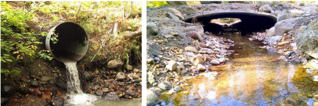
**Figura 4-1 Las alcantarillas pueden generar desniveles que representan barreras efectivas para diversas especies acuáticas (a, izquierda). El uso de estructuras especialmente diseñadas facilita el movimiento de diversos animales (b, derecha; tomada de <https://www.ausableriver.org/blog/safe-passage>).**
