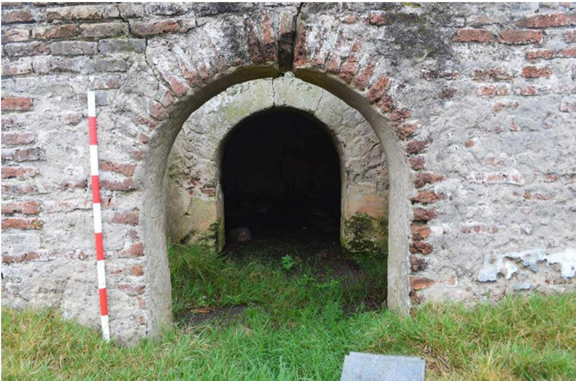
**Figura 9-40** Detalle de tramo inferior y arcos de medio punto
