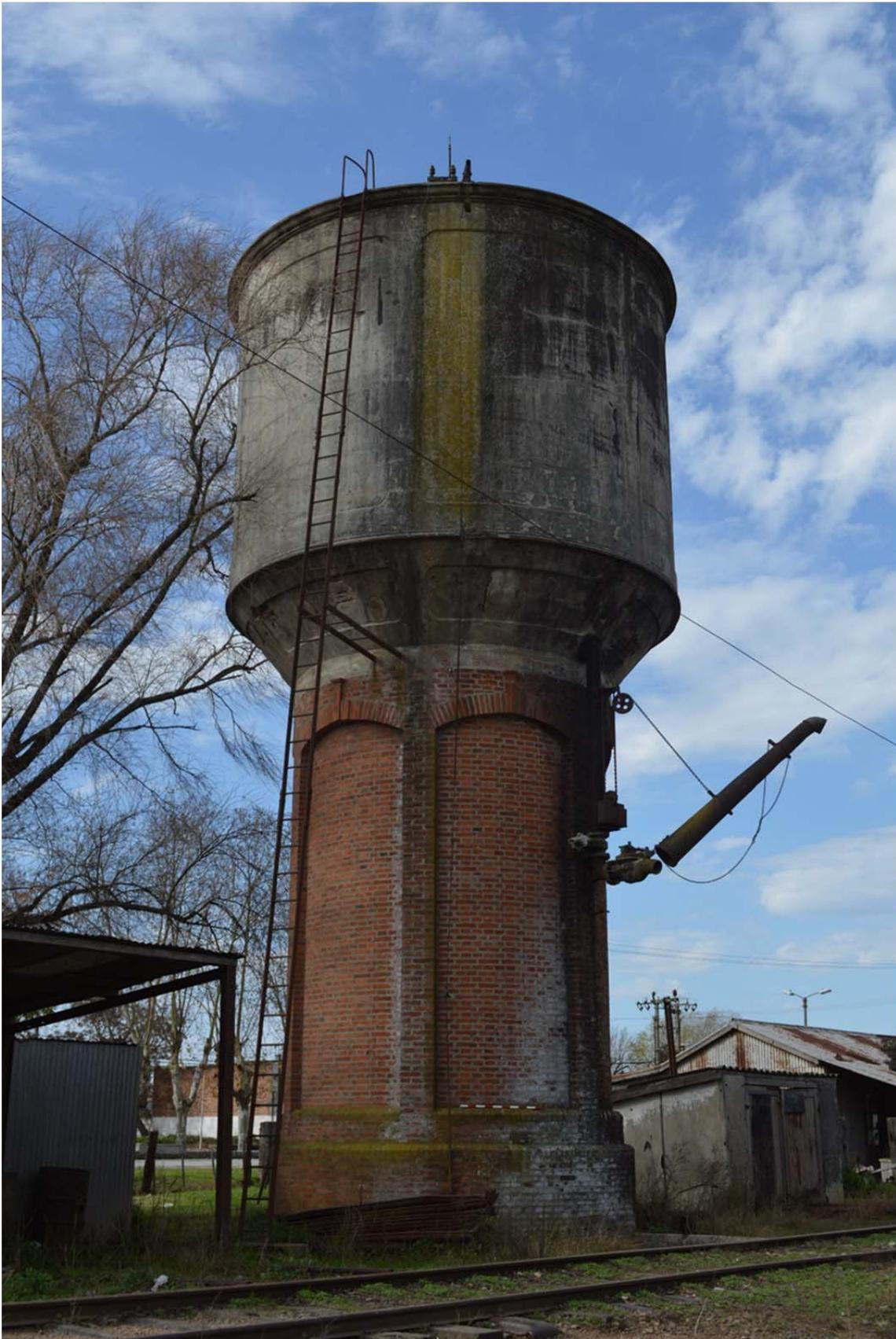
Figura 9-81 Depósito de agua elevado de la estación para alimentación de las máquinas
