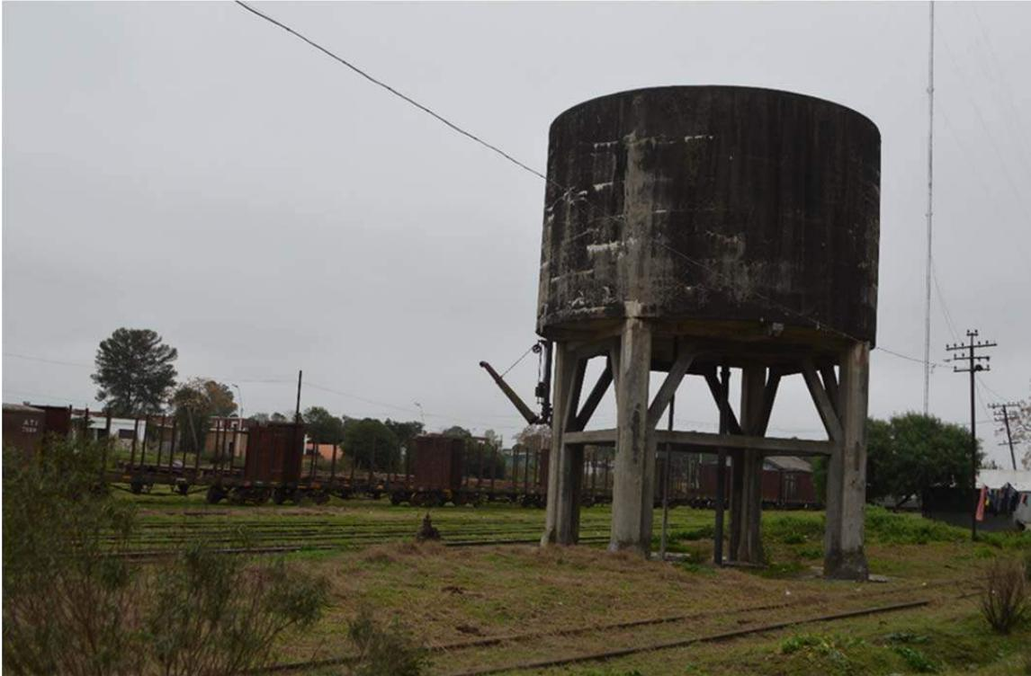
**Figura 9-109 Depósito de agua elevado para alimentación de las máquinas de la estación**
