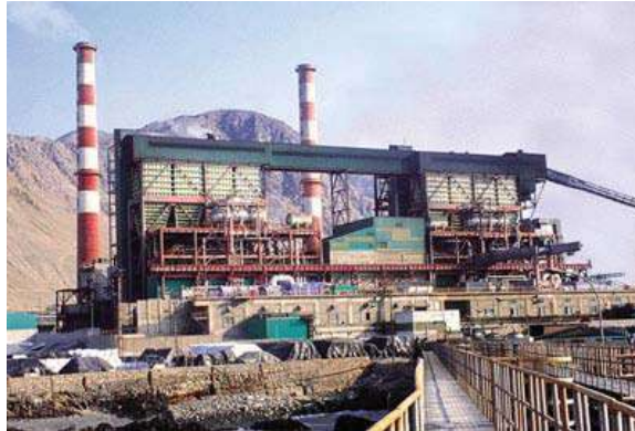
Fotografía 2.5-16. Central Nueva Tocopilla, Norgener
