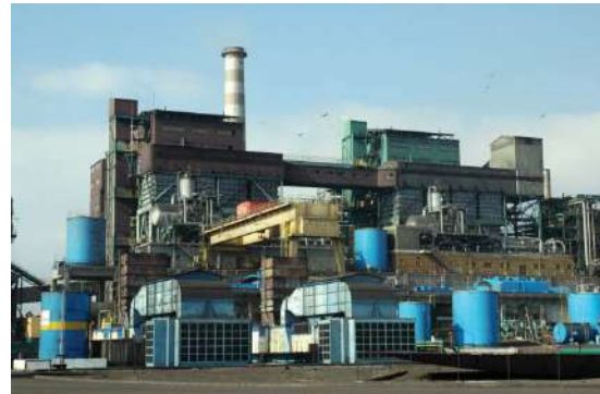
Central Termoeléctrica Tocopilla
