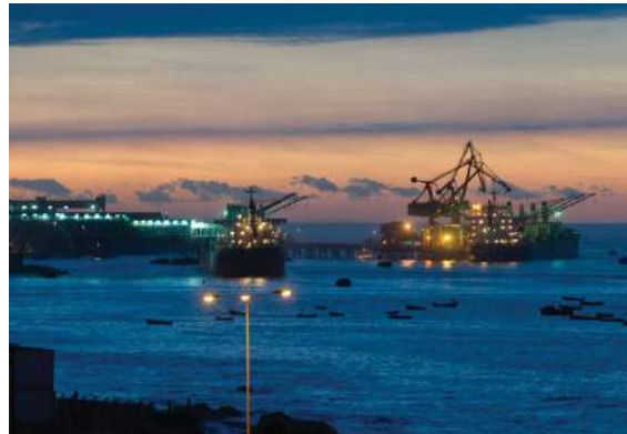
Fotografía 2.5-17. Puerto Tocopilla por la Noche
