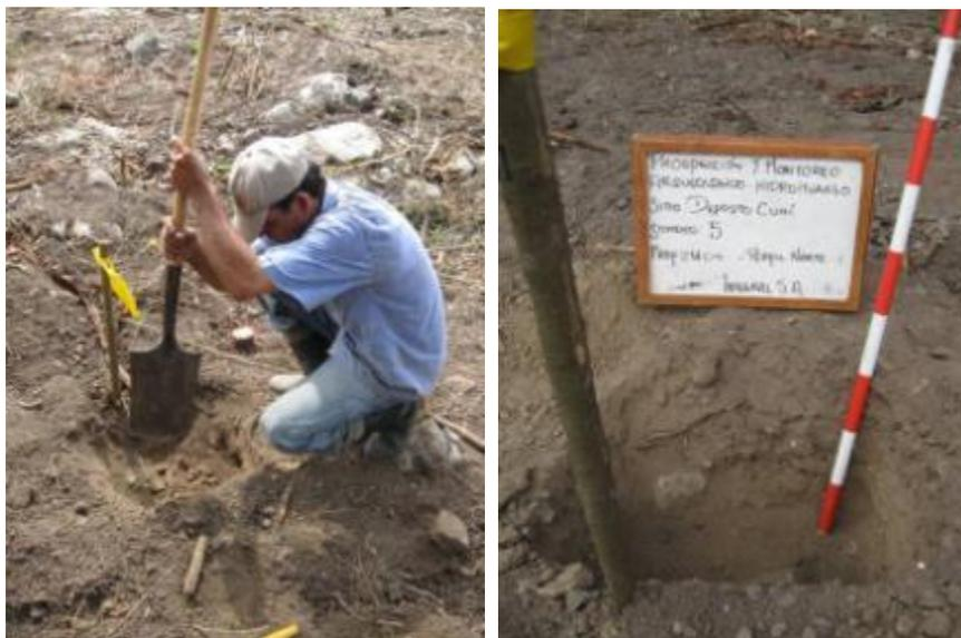
Fotografía 5.37. Sitio Depósito Tacui I. Realización de pozos de sondeo.
