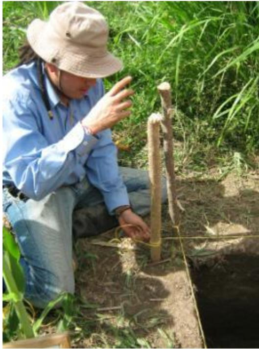
Fotografía 3.10 Nivelación de cuerdas durante el proceso de excavación
