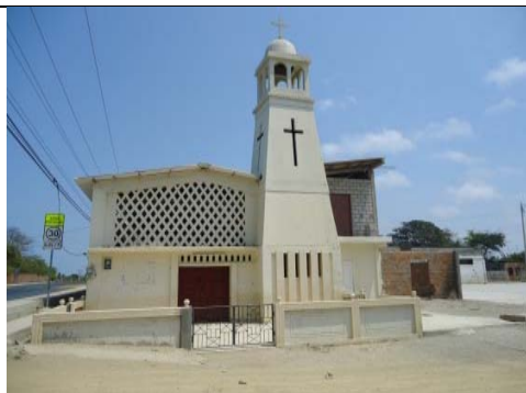
Foto 81: Iglesia – Data de Villamil Fecha: 11/09/2016 Fuente: Cardno
