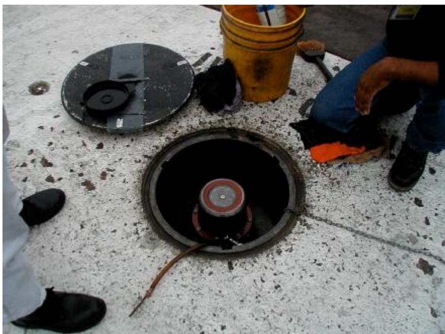
**Foto 20.** Toma para Abastecimiento de Combustible de Aviones en la Plataforma
