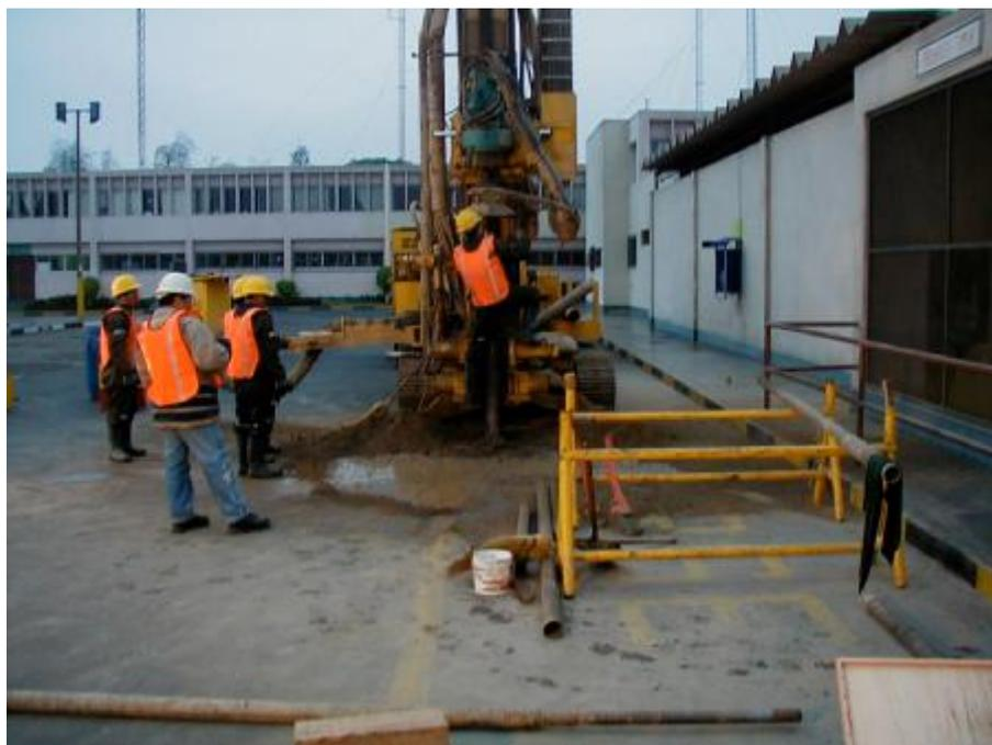
**Foto 19.** Instalación del Pozo de Monitoreo de Agua Subterránea BH-12.
