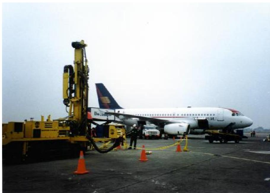
**Foto 2. Toma de Muestra de Suelos para Determinación de Pasivos Ambientales en la Plataforma**
